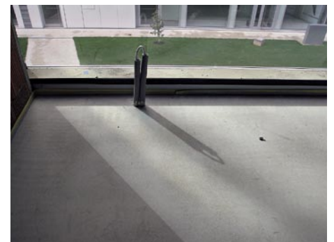
Hotový betónový poter po zatvrdnutí.
