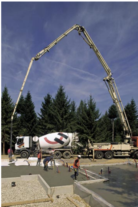
Bez potreby dodatočnej výstuže - vláknobetón vám dovezú s výstužou priamo z betonárne.
